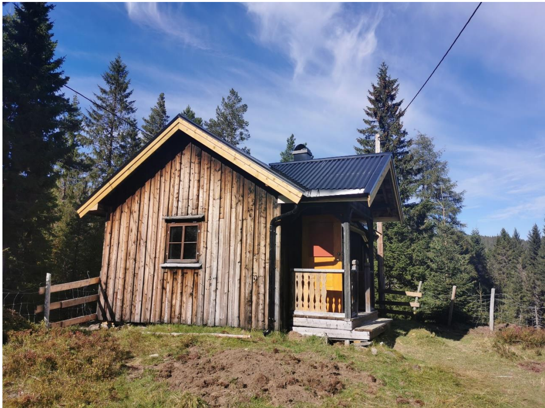
Bilde er fra Hytta på Sandholtan som er under restaurering.
