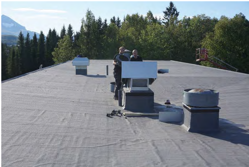
Takarbeid - Skogbrukets hus 3. september 2021.
