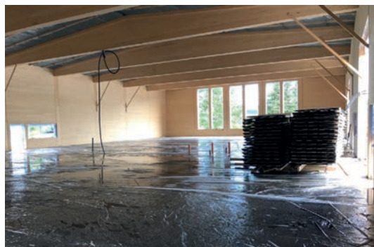
OPPLAND: Taket var på plass 16. mai, men fortsatt står det litt arbeid igjen før det nye bygget på Biri planteskole er klart til bruk til høsten.
