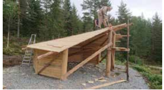
VESTFOLD: Den nye gapahuken på Konnerud er et satt opp som et samarbeidsprosjekt mellom blant annet skogselskapet i Buskerud og Vestfold.
