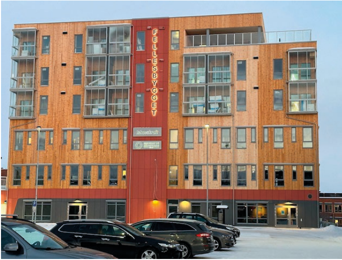
Mye tre i Fellesbygget i Alta.
